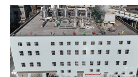
金川镍钴8200方重金属高盐废水零排子项一EPC+O项目
