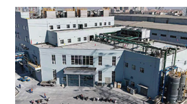
金川镍钴8200方重金属高盐废水零排子项二EPC+O项目
