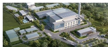
孝感市固废处置中心危废污水处理工程
