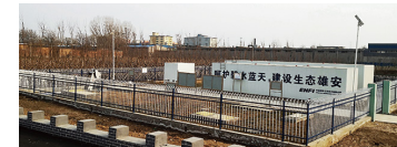
分散式傍水村庄生活污水治理工程
