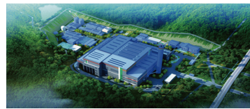
襄阳恩菲生活垃圾焚烧厂渗沥液处理工程
