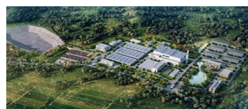
辽宁(锦州)再生资源产业园危废处置中心污水处理工程
