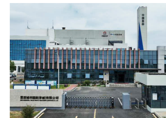
孝感市固废处置中心项目
