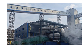
新疆有色五鑫铜业利用冲渣热能浓缩高盐废水项目
