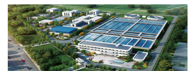
青州市东南部污水处理厂及配套管网建设工程
