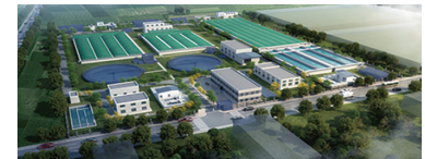
固安城区污水处理厂提标改造工程
