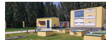
集中式村镇生活污水治理工程
