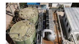
云南驰宏200方高氨氮废水处理合同能源管理项目
